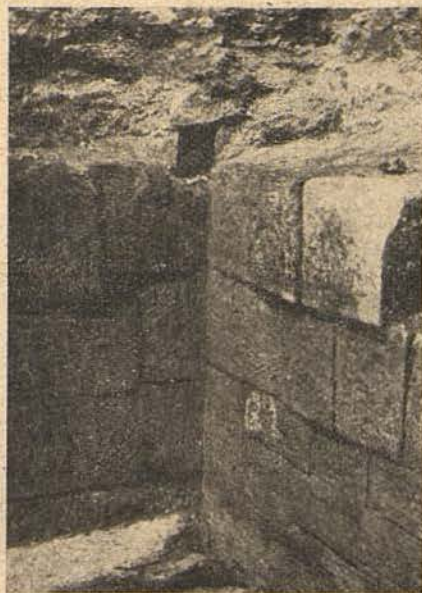
Фиг. 153. Отвор за подхранване на чешмите Fig. 153. Öffnung für die Wasserleitungen
